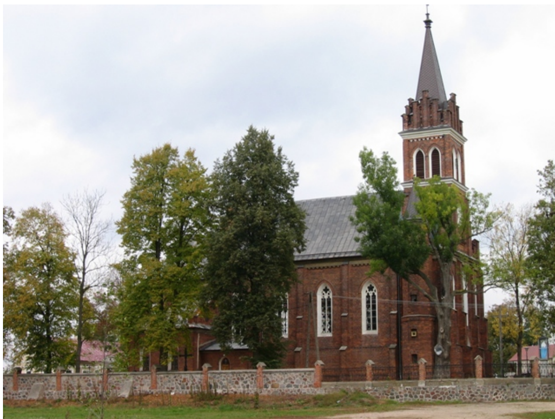
Kościół pw. Przemienienia Pańskiego w Lubani z 1887 r.
